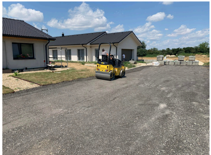
V časti novej IBV za Škôlkou sa nám podarilo v spolupráci zo Správnu ciest naviesť 650 ton asfaltového frézingu. Pán Struhárik nám ho s bágrom rozťahal a svojpomocne si ho obyvatelia lokality rozvalovali. Takto sa aspoň na chvíľku odstránili jamy a prašnosť.
