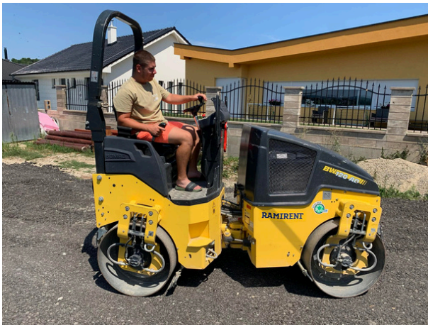
V časti novej IBV za Škôlkou sa nám podarilo v spolupráci zo Správnu ciest naviesť 650 ton asfaltového frézingu. Pán Struhárik nám ho s bágrom rozťahal a svojpomocne si ho obyvatelia lokality rozvalovali. Takto sa aspoň na chvíľku odstránili jamy a prašnosť.
