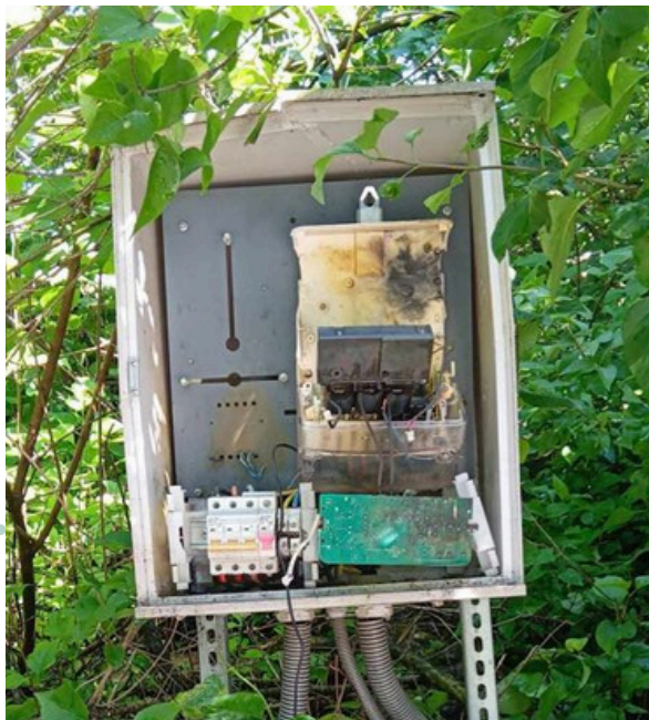
Silný blesk na Modrovke odpálil 4 kamery, 5 svetidiel a Palkovi Strakotovi elektrické hodiny
