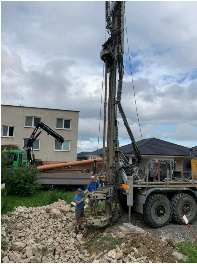
Rozšírenie trativodu v časti pred bytovkou. Po odbornej konzultácii s geológom a vodoinžinierom bol realizovaný hlbkový vsak 9,5 m perforovaný na úrovni 5,2 m, ktorý ma pomôcť s odvádzaním nadzemných aj podzemných vôd do časti tzv. váhového štrkového podlažia.
