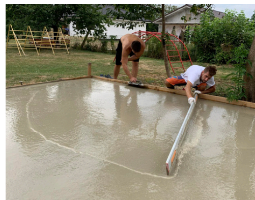
Základová doska pod pódium
