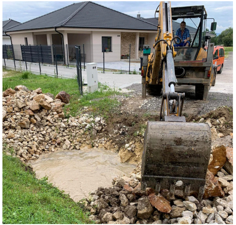
Rozšírenie trativodu v časti pred bytovkou. Po odbornej konzultácii s geológom a vodoinžinierom bol realizovaný hlbkový vsak 9,5 m perforovaný na úrovni 5,2 m, ktorý ma pomôcť s odvádzaním nadzemných aj podzemných vôd do časti tzv. váhového štrkového podlažia.
